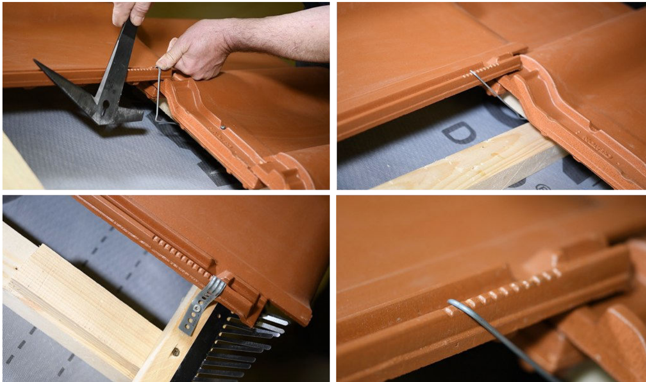
Beütős, beakasztós és az univerzális viharkapocs beépítése, továbbá beakasztós viharkapcsoknak kialakított barázdásor az oldalhornyban
