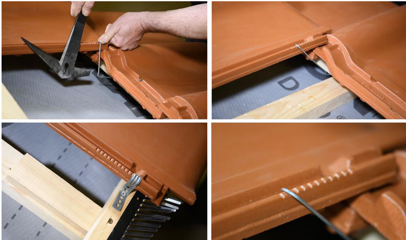
Beütős, beakasztós és az univerzális viharkapocs beépítése, továbbá beakasztós viharkapcsoknak kialakított barázdasor az oldalhornyban
