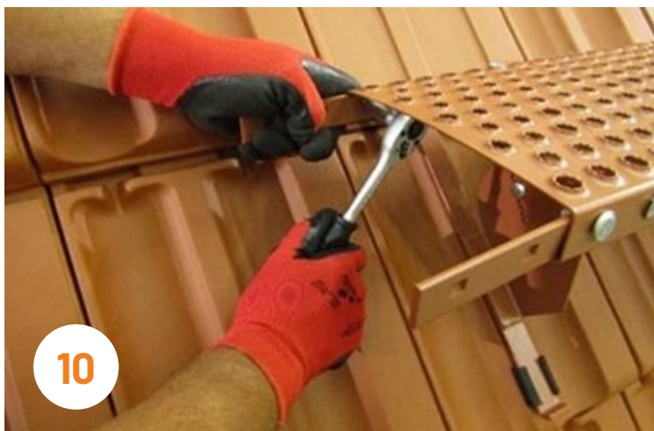
10 Folytonosított járórácsok esetén használja a "járórács összeszerelő szett"-ben található 2 db toldóelemet.
