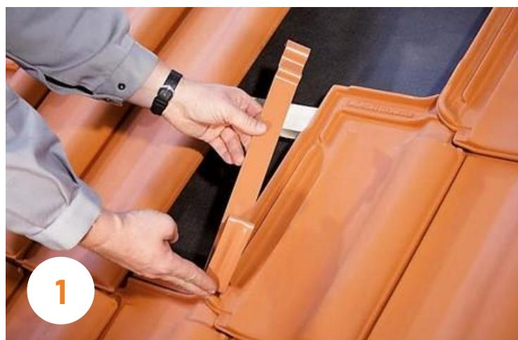
A hófogót közvetlenül a tetőcserépre kell felhelyezni a cserépfedés készítésével egyidőben.
