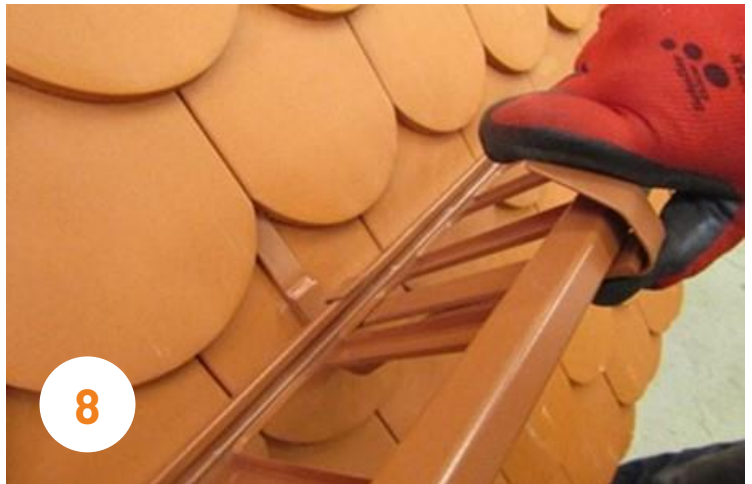
Kézzel hajtsa le a felső rögzítő pántot, így a rács nem képes kibilleni a tartóból.
