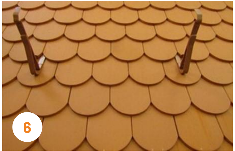
A tartókonzolok fölé így alapcserep kerül.
