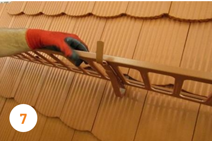
Helyezzük be a hófogórácst az erre kialakított sínbe! Ügyeljen arra, hogy a hófogórács konzolos túllógása nem lehet nagyobb, mint a támaszköz 1/3-a!
